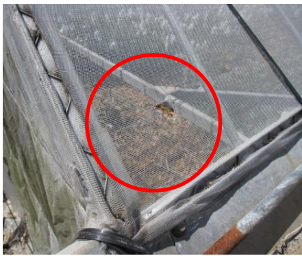
ネット等の破れの補修
