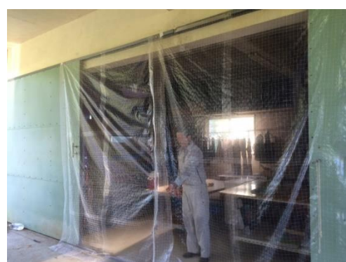
集荷場入口のネット設置
