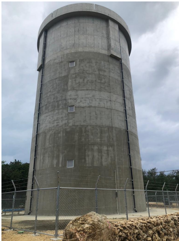
竹富新配水池(令和5年度竣工)
