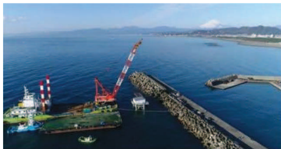
反射波を利用する神奈川県平塚市での実証試験（発電量 45kW）
