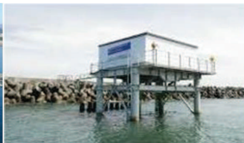
反射波を利用する神奈川県平塚市での実証試験（発電量 45kW）
