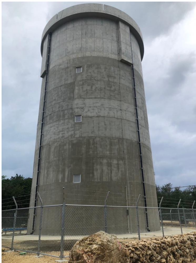
竹富新配水池(令和5年度竣工)
