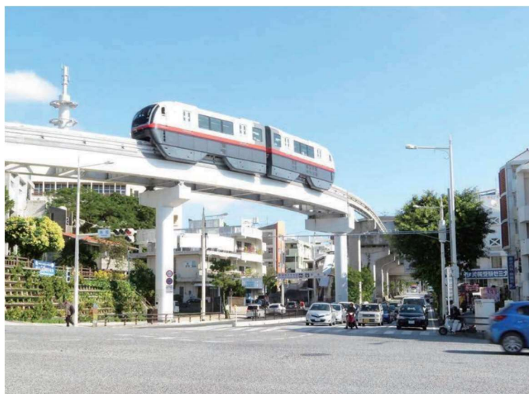
＜整備後＞県道82号線・県道29号線
