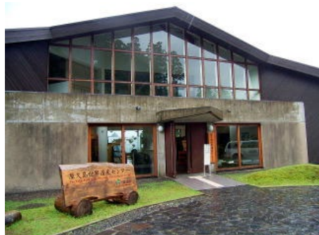
屋久島自然遺産センター外観 構造：鉄筋コンクリート造及び木 造二階建て 建築規模：479m 2
