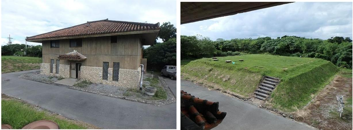
【写真：竹富浄化センター】左：管理棟、右：水処理施設（接触酸化法）
