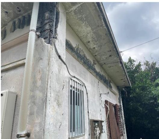
島内には教職員宿舎が5棟11戸整備されているが、最も古い建物では築39年が経過し、特に2号棟では鉄筋の腐食により外壁や柱の亀裂、剥離が著しく進み、鉄筋がむき出しになるなど非常に危険な状況にあるため緊急的に施設の更新を行う必要がある。なお、更新にあたっては教職員に限らず、つばさ寮監（地域おこし協力隊）の寄宿舍も併せて検討する必要がある。
