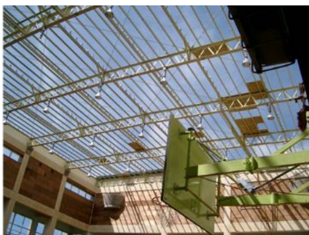
⑳ 暴風で屋根が吹き飛ばされた体育館と落下した風力発電塔の回転翼（沖縄気象台提供）
