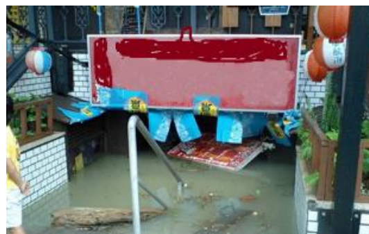
⑥ 那覇市国際通りの地下ビル (沖縄県警提供)
