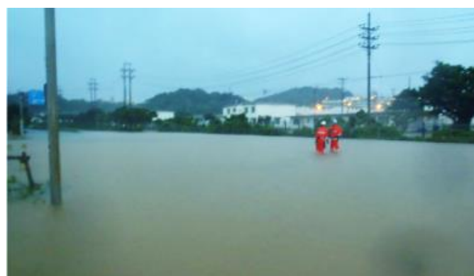
⑨ 2014. 7. 9 比謝川の氾濫で広く冠水した道路(沖縄市消防本部提供)
