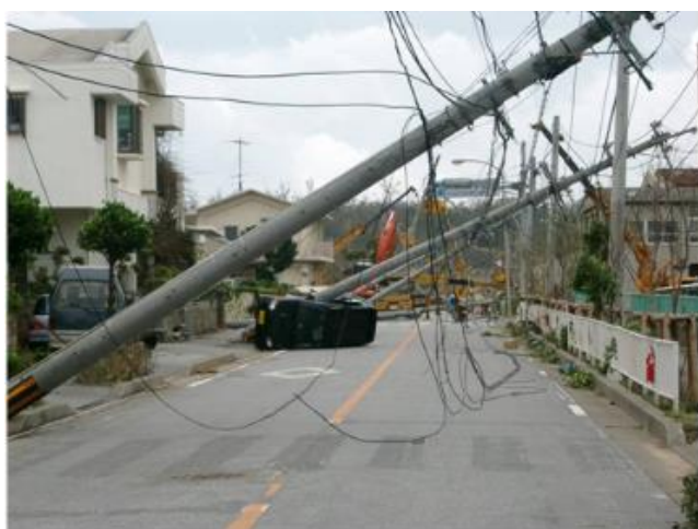
⑱ 2003. 9. 11 暴風で倒壊した電柱と横転した車両（沖縄気象台提供）
