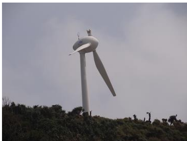
暴風で破壊された風力発電塔の回転翼と転倒した電柱（沖縄気象台提供）
