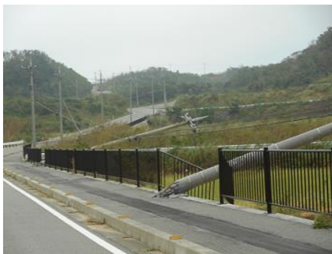
暴風で破壊された風力発電塔の回転翼と転倒した電柱（沖縄気象台提供）
