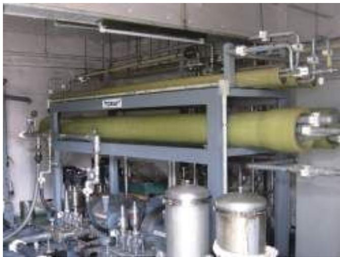
海水淡水化装置(逆浸透膜)
