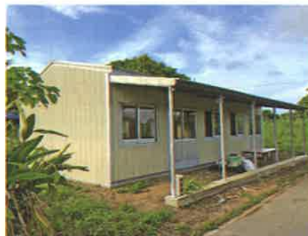
↑つばさ寮向かいに建設中
