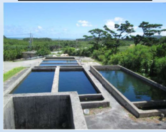
東部第二区浄水場【ろ過池】
