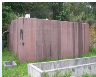
東部第一区浄水場【配水池】
