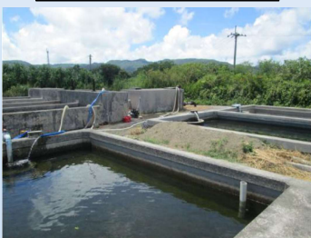
上原第一浄水場【ろ過池】
