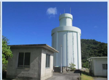
舟浮原水槽・配水池
