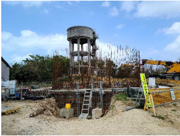
水道施設の再整備
