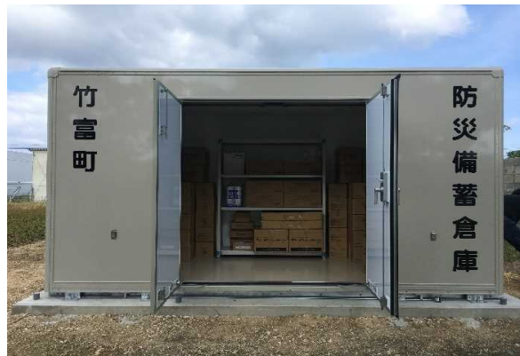
防災備蓄倉庫の整備・維持管理
