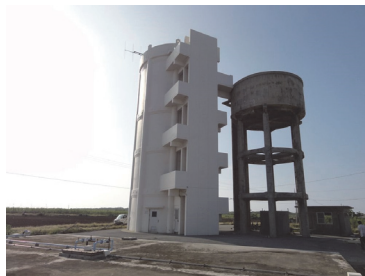
写真3.1-2 海水淡水化施設 〔波照間島〕
