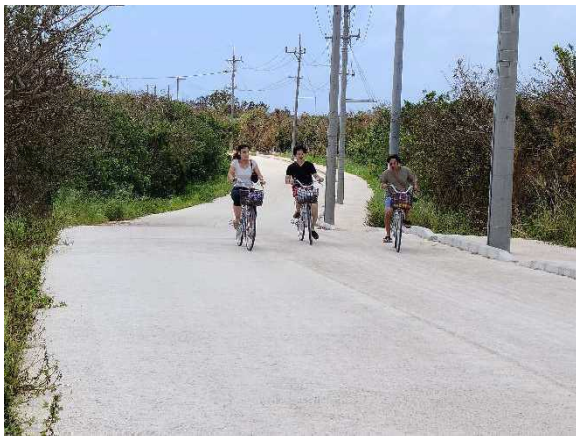
来訪者が利用する道路の整備・維持管理
