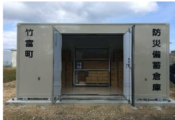
防災備蓄倉庫の整備・維持管理
