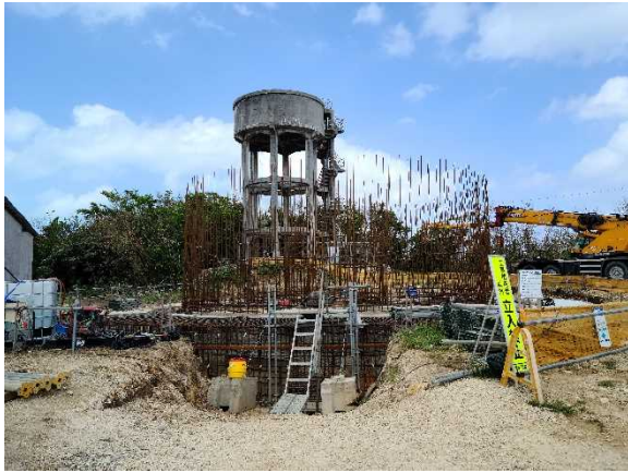
水道施設の再整備
