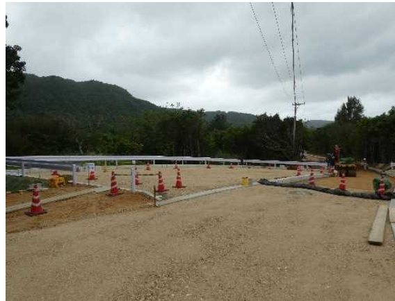
来訪者の利用に対応する駐車場の整備
