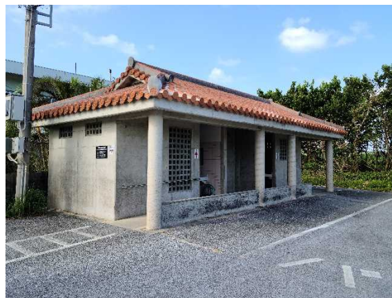
公共トイレの整備・維持管理
