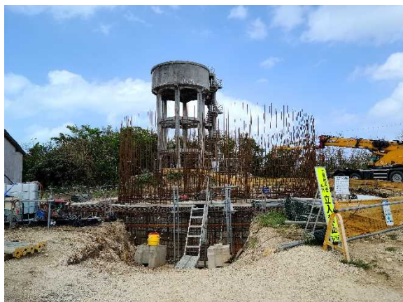
水道施設の再整備
